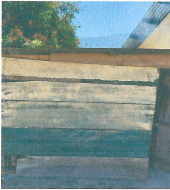
Foto 1: Mejoramiento de cubierta de bodega escolar.
